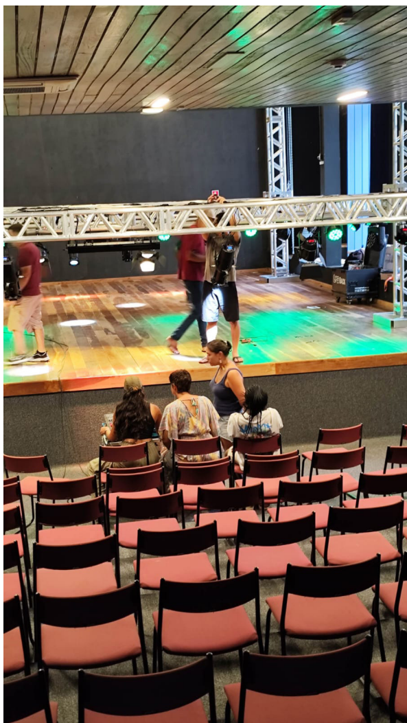
Estrutura de iluminação sendo instalada no teatro
