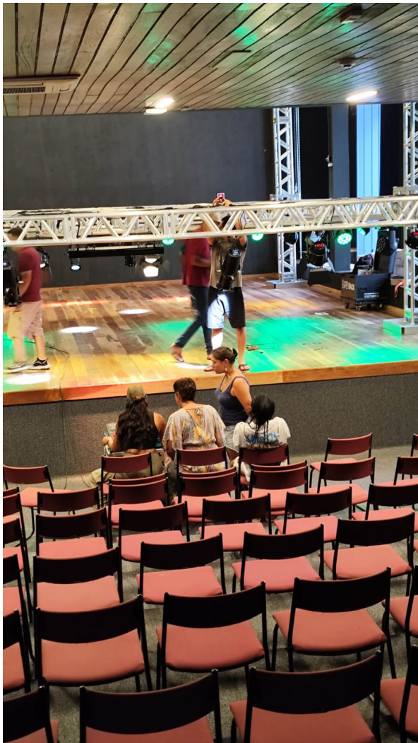
Estrutura de iluminação sendo instalada no teatro
